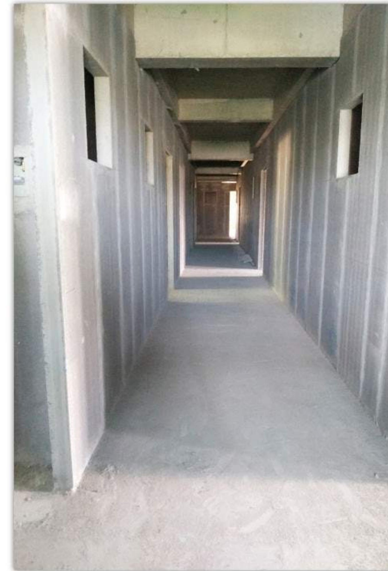
Tấm tường sau khi lắp dựng
